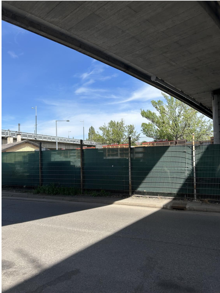
U-Bahn Brücke Spittelau
