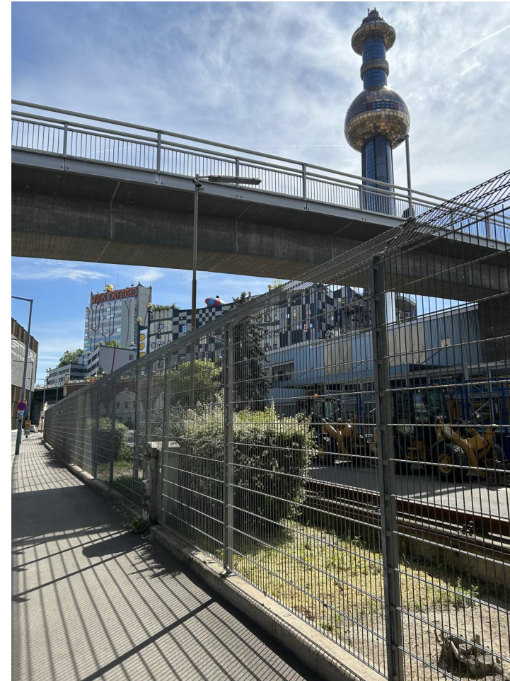
Rad- und Fußgängerbrücke von Bahnhof Spittelau Richtung 20.Bezirk
